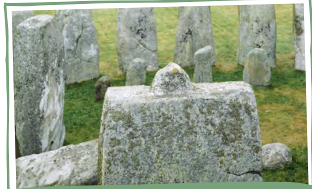
Sommet d'une sarsen verticale montrant la mortaise et le tenon utilisés pour maintenir les linteaux en place.
